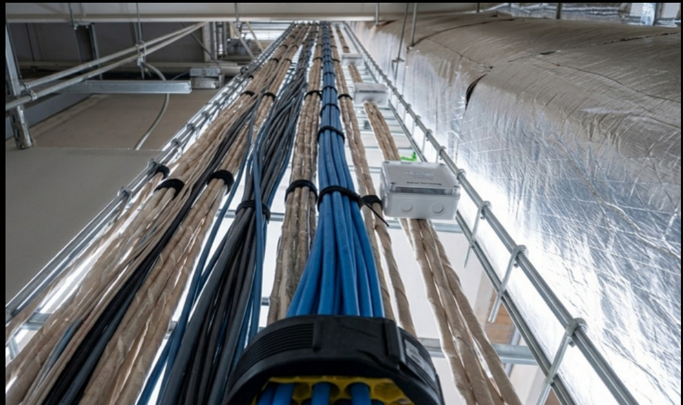
Canalización y tendido de cableado estructurado
